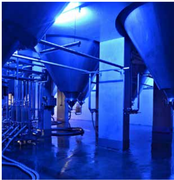
Im Gär- und Lagerkeller der Brauerei
